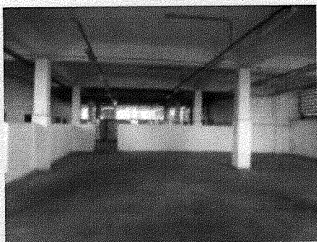
Área de estoque - 2º pavimento
